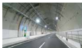
国土交通省 トンネル内壁視線誘導塗装
